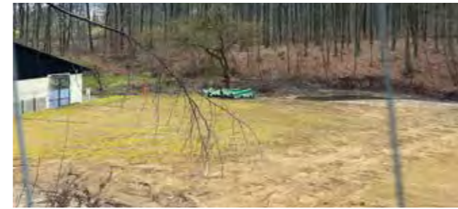
Still ruht der Wald: Auf der Baustelle herrscht derzeit Stillstand
