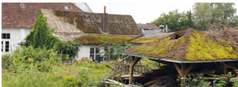
Derzeit noch wilde Wüstenei: Das ehemalige Büscher-Hotel und der einst idyllische Biergarten werden abgerissen.
