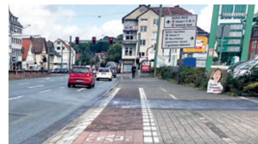
Umstrittener Plan: Die Artur-Ladebeck-Straße soll eventuell zu Lasten des Autoverkehrs einen „geschützten Radweg“ bekommen.
