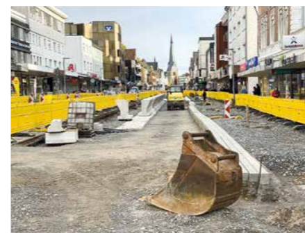
Bereitet immer mehr Sorgen: Die Großbaustelle Brackweder Hauptstraße
