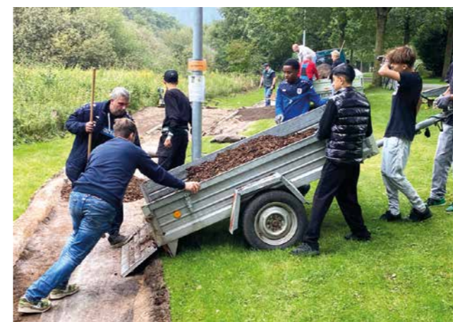
Zuuugleich!: Bei den Sanierungsarbeiten war Teamwork gefragt.
