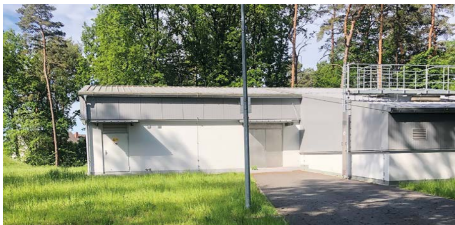
Im Grünen: Das Ummelner Wasserwerk wird aufwändig saniert.
