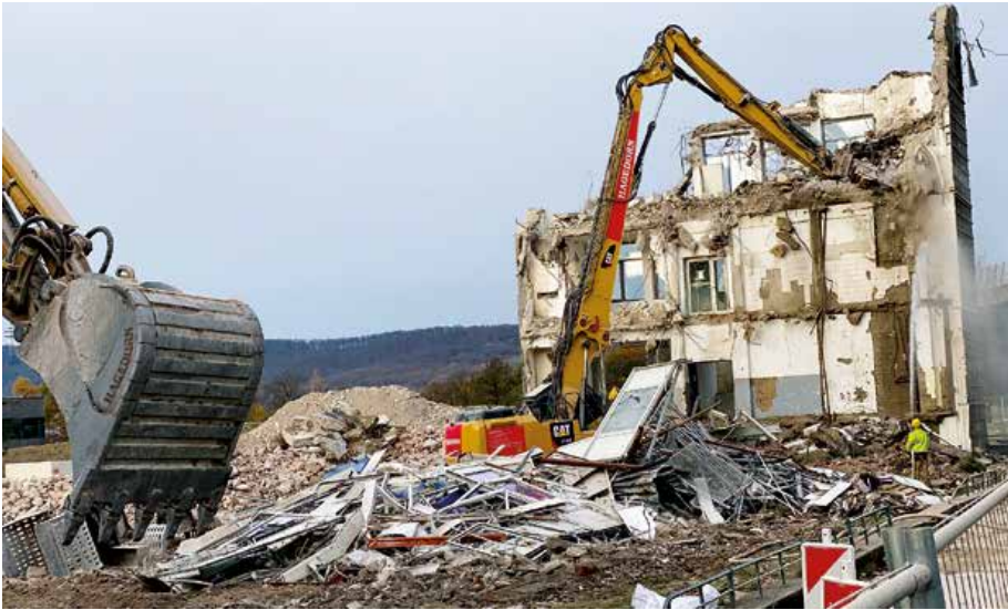
Da geht's zur Sache: Abrissbagger pulverisieren die ehemaligen Produktionshallen.
