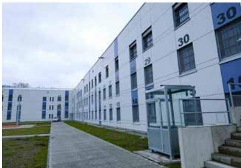
Schöne Fassade: Das neue Hafthaus wurde in Stahlmodulbauweise errichtet.
